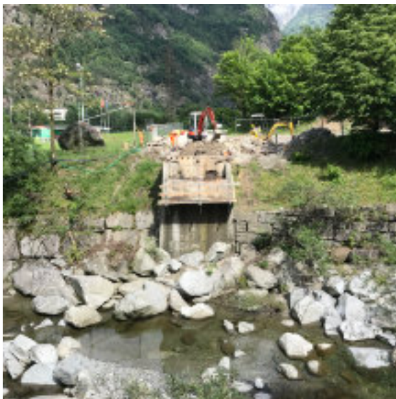
RISANAMENTO SPALLA LATO CAMPO DI CALCIO
