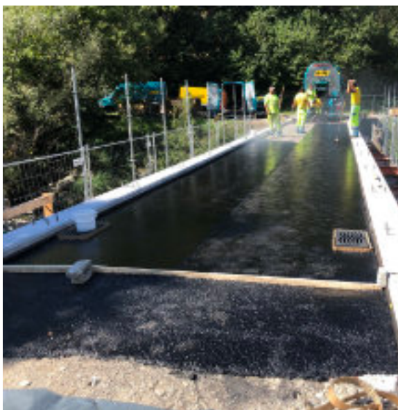
OPERE DI PAVIMENTAZIONE (ASFALTO FUSO)
