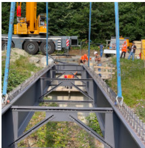
POSA NUOVA STRUTTURA METALLICA
