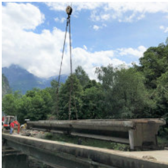
TAGLIO E RIMOZIONE PIATTABANDA
