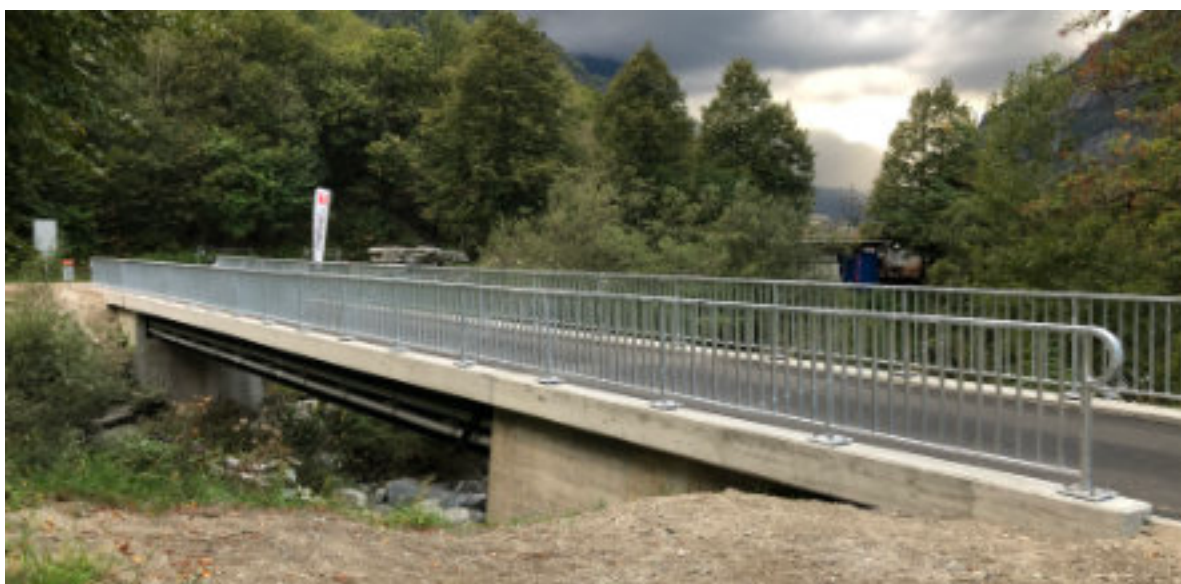
SITUAZIONE FINALE, RISANAMENTO ULTIMATO
